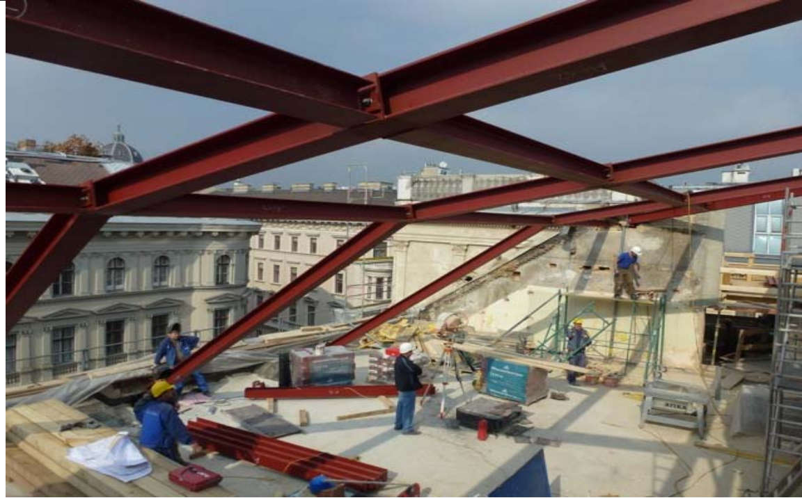
FOTO: Stahltragwerk der neuen Bürofläche im 4. Obergeschoss
