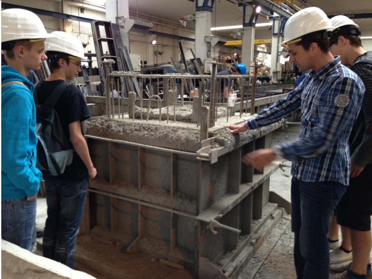
FOTO: Das Köcherfundament wird „auf den Kopf gestellt“ betoniert.
